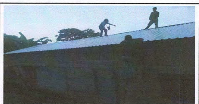
Foto 5: Cambio de cubierta de techo de lámina troquelada.
