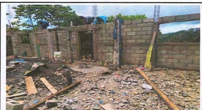
Foto 3: Fundición de solera.
