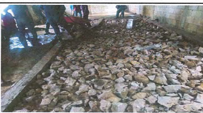
Foto 4: Fundición piso concreto
