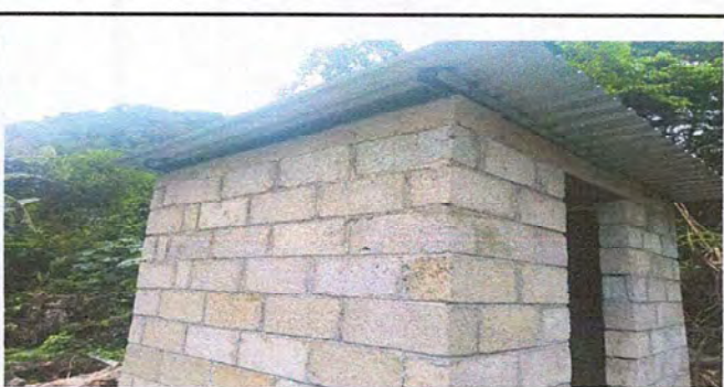
Foto 6: Rehabilitación de Baño y cambio de cubierta de techo de lamina troquelada.
