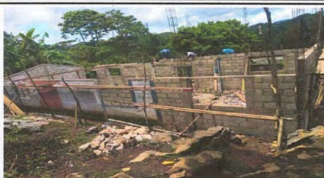
Foto 2: Ampliación de aula multigrado.
