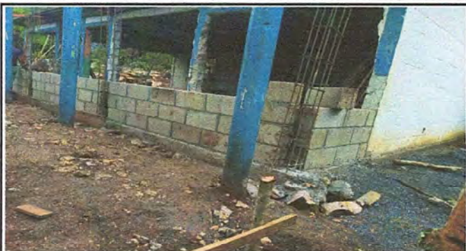
Foto1: Se colocó las columnas de 6 varillas con zapata.
